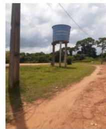
Figura 2: Caixa d'água Povoado Serraria Foto: Kleber Veras Cordeiro
